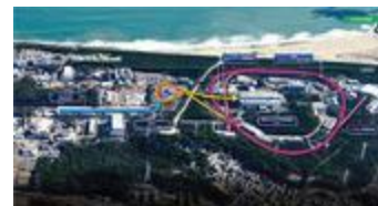
19.【東】J-PARCセンター
